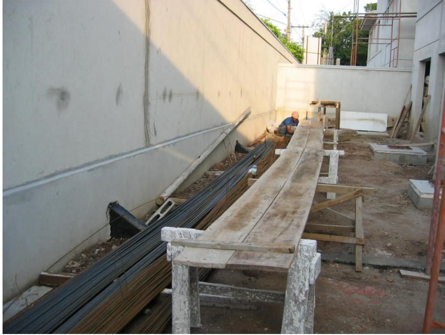
**Figura 2.1 - Armazenamento dos vergalhões de aço em uma obra.**
